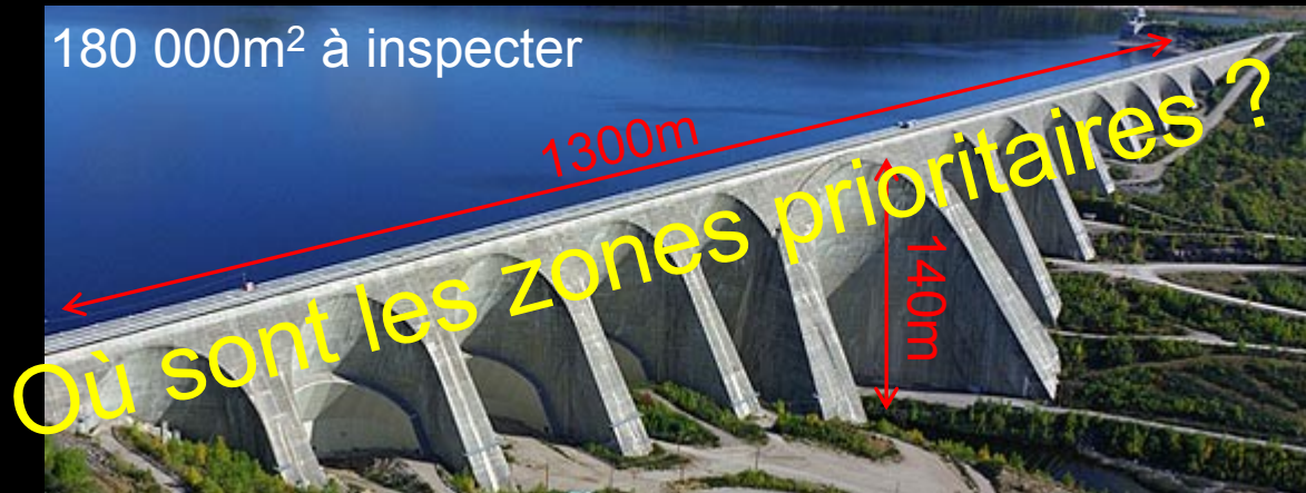
Centrale Manic-5. Photo : Hydro-Québec
