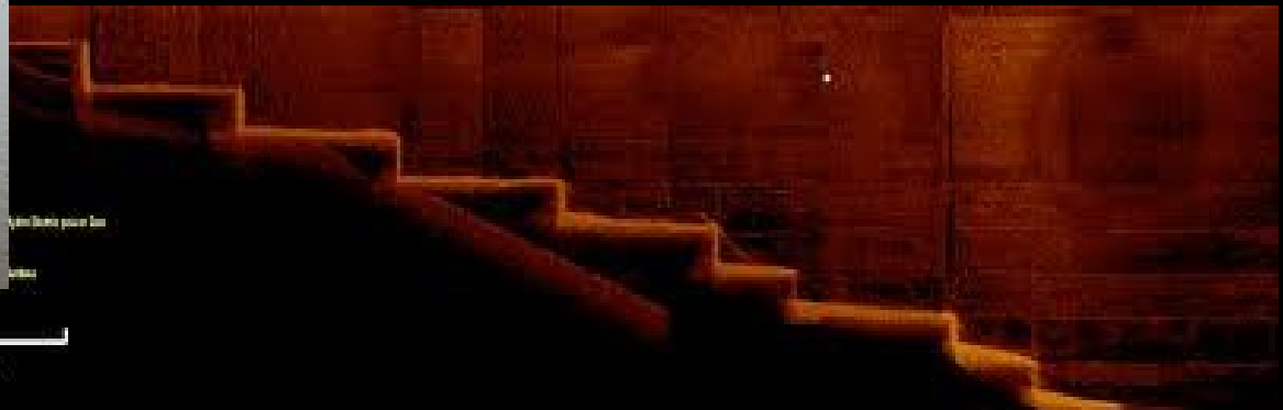
Déploiement et mosaïque résultant d'un balayage par MS1000 sur un mur de barrage au Laos (Photo: Kongsberg)
